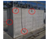
Vue face Nord et Est du bloc instrumenté (capteurs et système d'acquisition MISTRAS)
